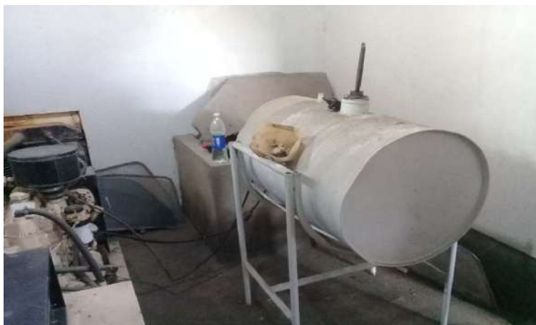
Fuente: Inspección técnica. Consultor Ambiental, 2018.
