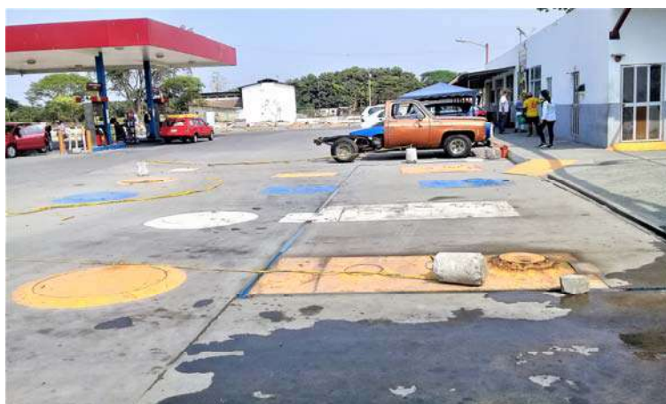
Ilustración 4.7. Área de tanques de combustible de la estación de servicio
