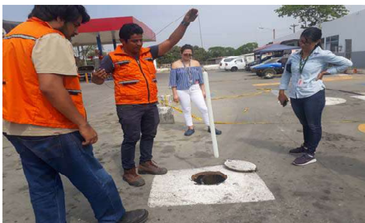
Fuente: Inspección técnica. Consultor Ambiental, 2018.
