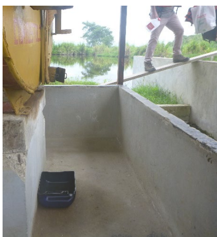
Cubeto de contención de concreto
