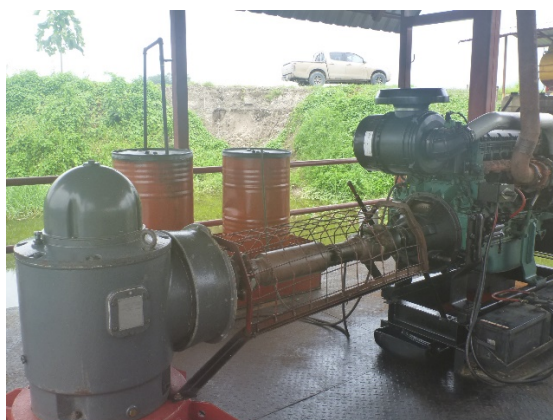
Cubeto de contención debajo de motor
