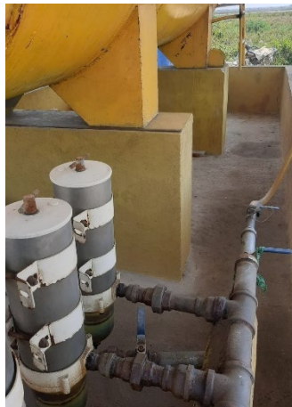
Cubeto de contención de concreto
