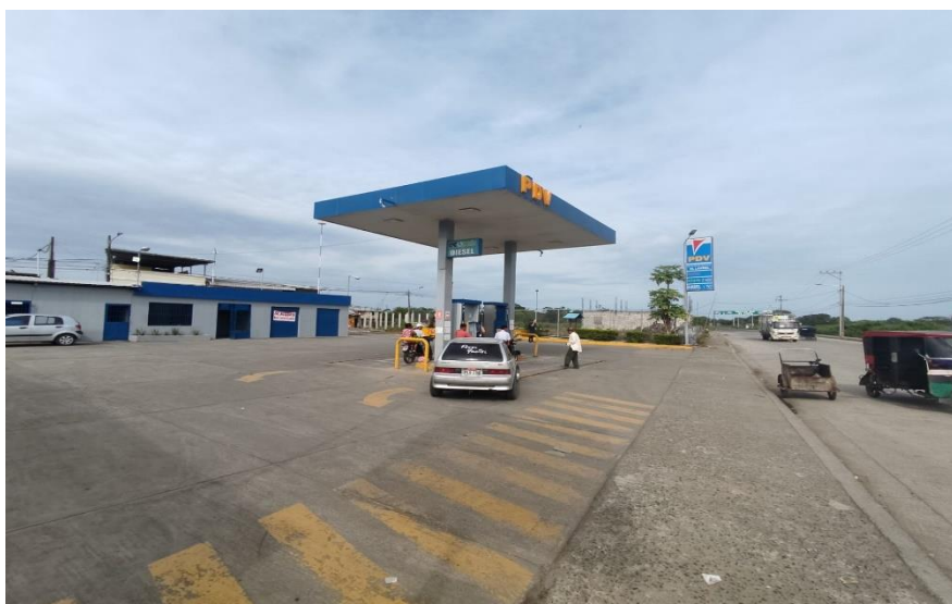
fotografia 1.. VÍA DE INGRESO A LA ESTACIÓN .
