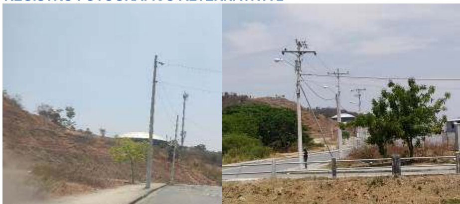
Fotografía 59. Vista Tanque Mi Lote
