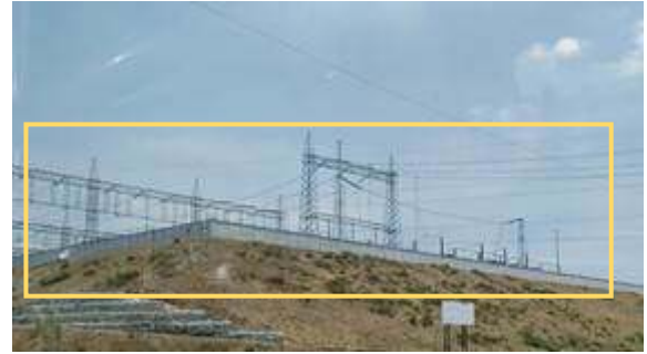
Fotografía 10 Central eléctrica aledaña a la línea del acueducto
