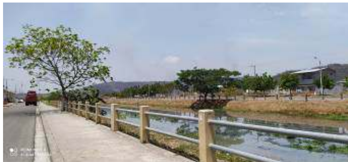
Fotografía 57. Vista puente a través de Estero San Eduardo sector Mi Lote
