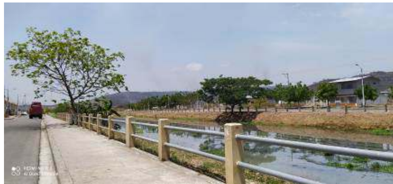
Fotografía 4 Vista puente a través de Estero San Eduardo sector Mi Lote
