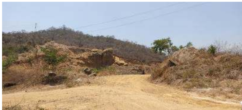
Fotografía 61 Acceso a nuevo reservorio en Ciudad Olmedo
