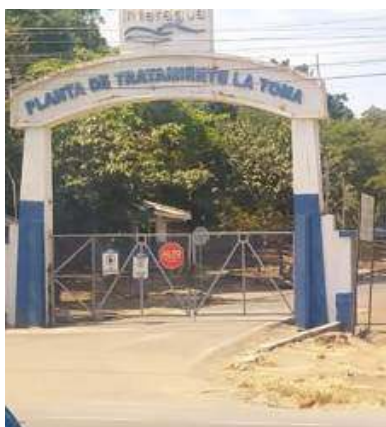
Fotografía 35 Instalaciones de la Planta de agua potable La Toma.
