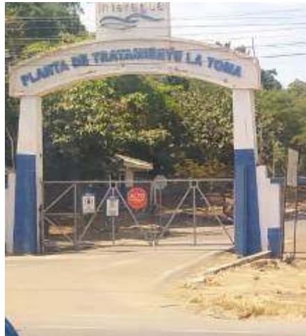
Fotografía 38. Entrada principal PTAP La Toma
