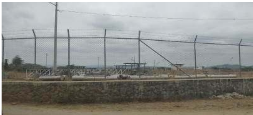
Fotografía 53 PTAR Planificada Mi Lote
