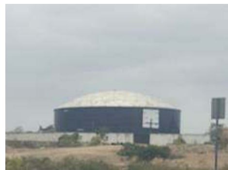
Fotografía 18 Tanque de reserva Ciudad Victoria
