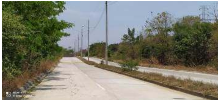
Fotografía 49. Cruce de vía Chorrillos hacia Subestación Eléctrica Ruta Quinto Acueducto
