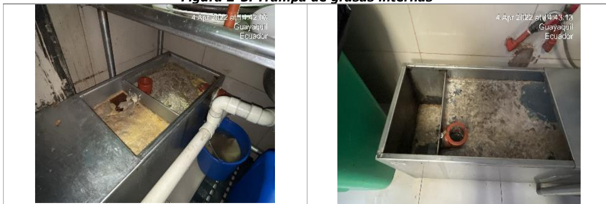
Figura 2-5. Trampa de grasas internas
