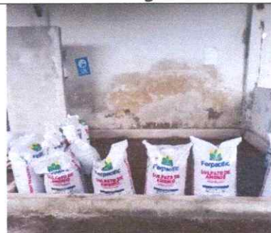
Área de mezcla, con cubeto antiderrames
