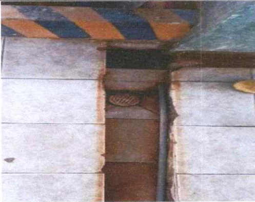
Canales para salida de agua
