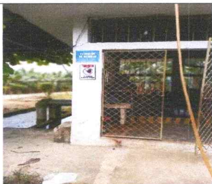
Exterior estación de bombeo 1.
