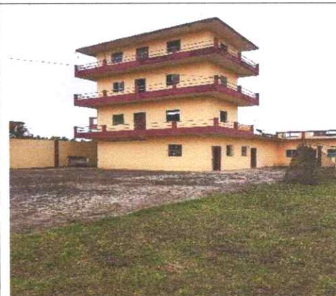
Area de Vivienda principal
