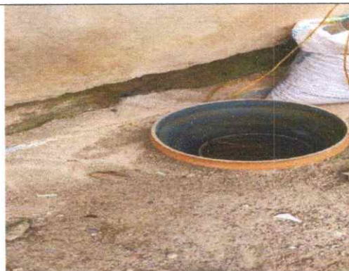
Abertura para mantenimiento de trampa de agroquímicos.
