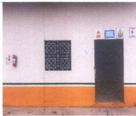
Exterior bodega desechos especiales
