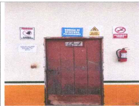
Exterior bodega de desechos peligrosos
