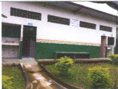
Área de sanitarios y duchas, para hombres y mujeres en área de empacadora.
