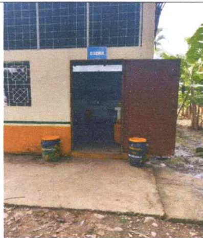
Recipientes para deposito de desechos comunes exterior cocina
