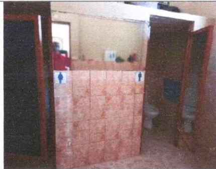
Área de sanitarios de área social y administrativa
