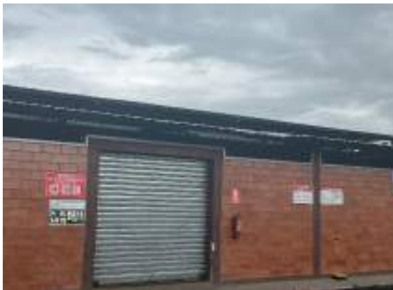
Fotografía 1-49. Bodegas de almacenamiento de fertilizantes de la Hacienda Bananera Benjamín con su respectivo sistema de señaléticas alusivas medidas de información y prohibición y sistema contra incendios (extintor), cerramiento que impide el acceso a personal no autorizado, techado, ventilación natural.
