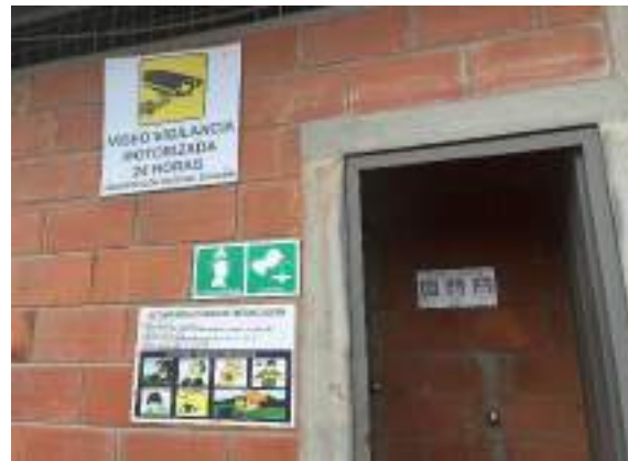
Fotografía 1-41. Ducha de emergencia con su correspondiente sistema de señalización.
