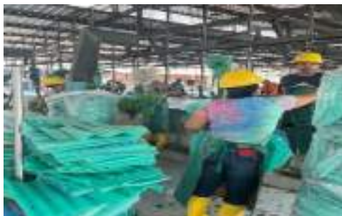
Fotografía 1-17. Retiro de separadores
