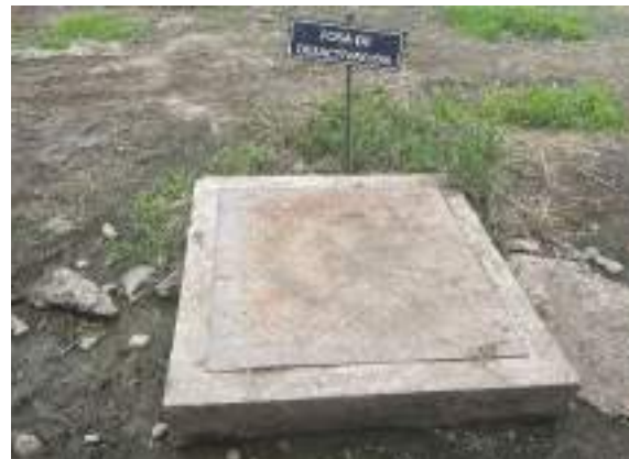
Fotografía 55. Fosa de para inactivar los compuestos activos de las trazas de agroquímicos; la misma que se utiliza en caso de generarse aguas residuales provenientes del área de triple lavado y/o área de mezcla.
