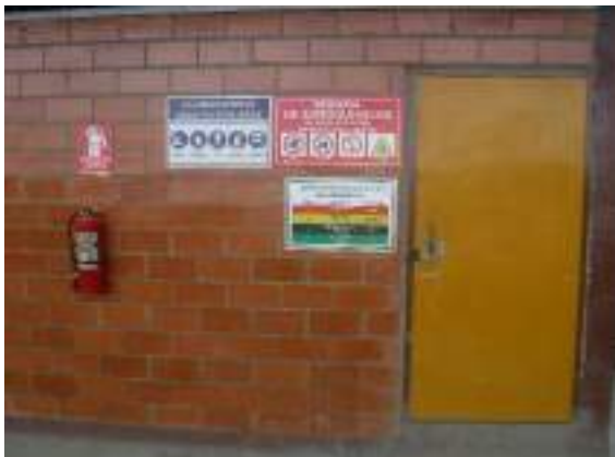
Fotografía 1-40. Área de almacenamiento de agroquímicos con su correspondiente sistema de señalización.
