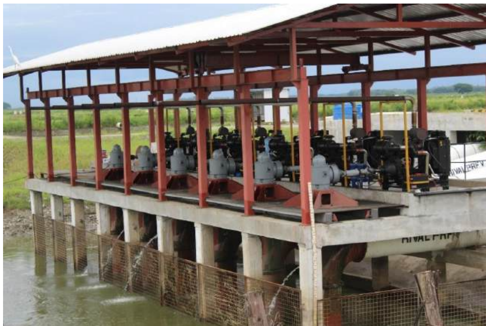
Figura 4.1-23. Estación de bombeo de la camaronera Puerto Inca 1 Elaborado por: Equipo consultor, (2025)
