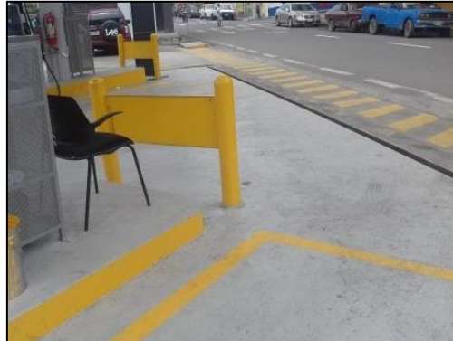
Ilustración 6. Canales perimetrales de la zona de despacho de combustible
