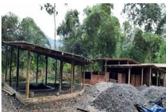
Foto 11.- Cabañas de alojamiento en construcción
