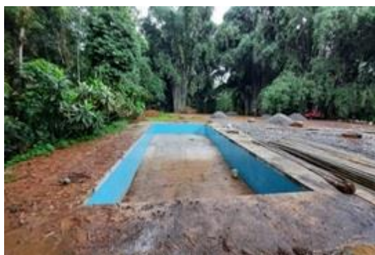
Foto 10.- Piscina en construcción
