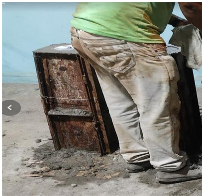
CONSTRUCCION DE HITO
