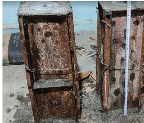
HITO FUNDIDO CON HORMIGON HIDRAULICO CON LAS MEDIDAS INDICADAS (0.70 m. DE ALTO)
