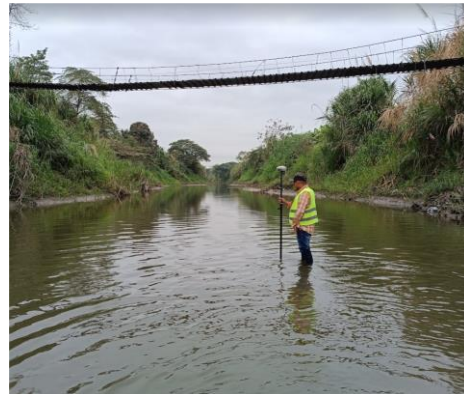
LEVANTAMIENTO DE LA SOLERA DEL RIO CHIMBO
