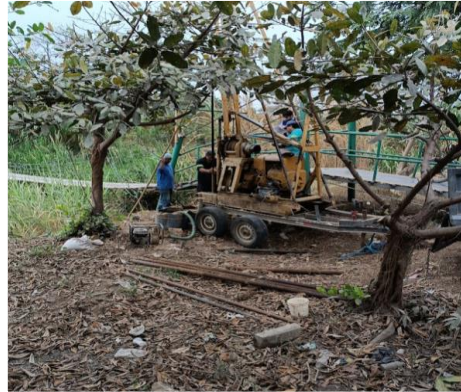
LEVANTAMIENTO A DETALLE DEL PUENTE EXISTENTE
