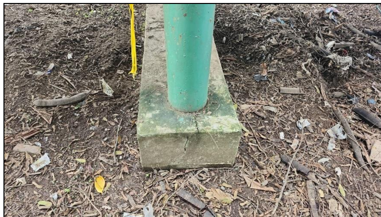
Figura 4. Figuras en pilas del puente del lado de Cone
