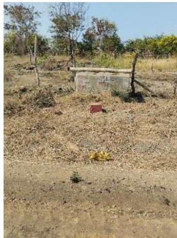
Fotografía de tanque sistema de agua
