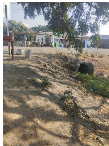
Alcantarilla existente absc. 0+034.41
