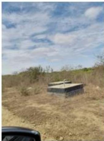
Cajas de revisión por donde pasa La tubería de agua potable
