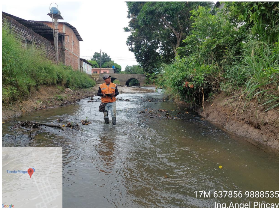
Levantamiento topográfico a detalles de los ríos.
