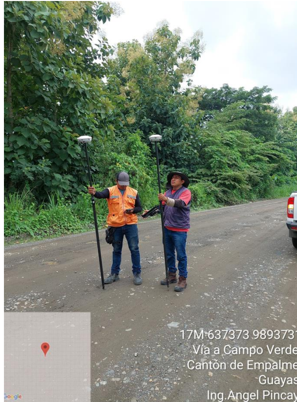
Levantamiento topográfico a detalles de la vía
