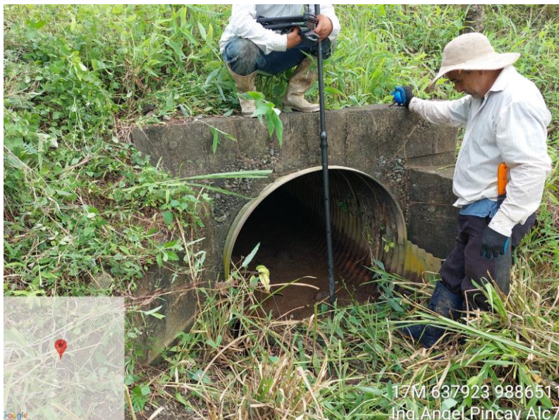
Levantamiento topográfico a detalles de alcantarillas y ductos
