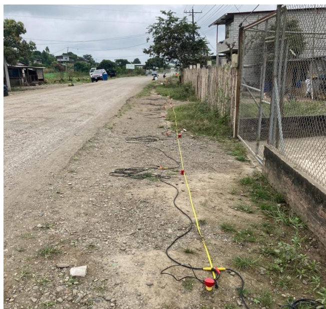
Foto 4. Arreglo geofísico Puente nuevo
