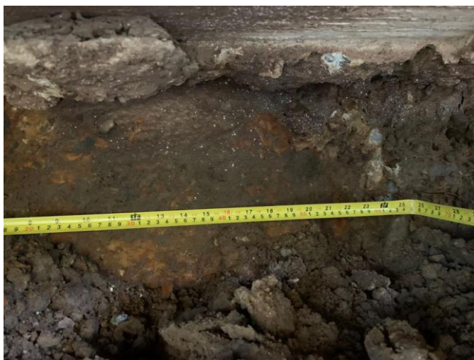
Foto 1.- Descubrimiento de la camisa metálica de pilotes prebarrenados de 0.60 m de diámetro.
