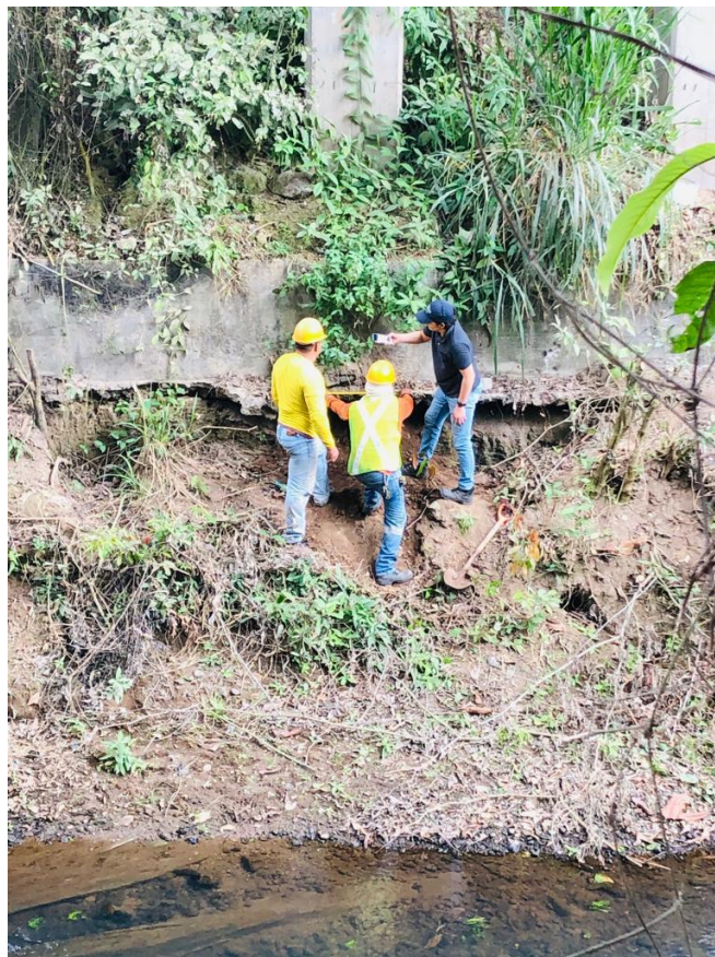
Foto 2.- Descubrimiento de la camisa metálica de pilotes prebarrenados de 0.60 m de diámetro.
