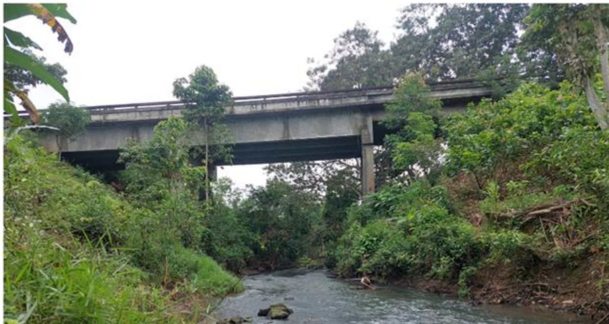
Figura 2: Puente sobre el río Jermud, 1+100 (visto desde aguas arriba)
