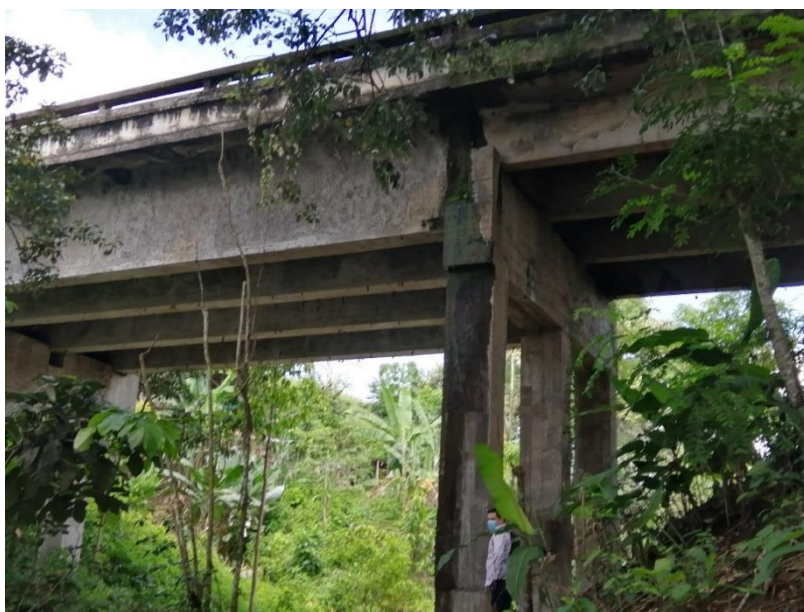
Ilustración A2. Vista lateral del puente río Jermud.
