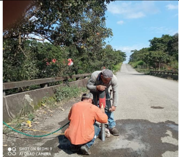
Ilustración B2. Toma de núcleo de Ho. en losa del tablero del puente
