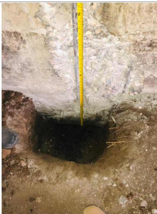
Ilustración C5. Acero de refuerzo en el estribo.
