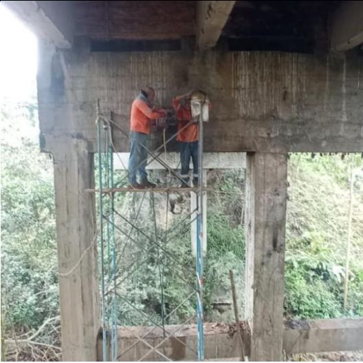
Ilustración B1. Toma de núcleo de Ho. en viga cabezal del puente
