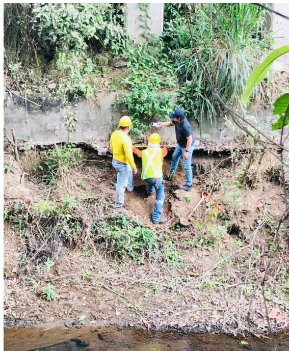
Ilustración 5. Fotografía de la cimentación de la Pila en la abscisa 1+121.70
