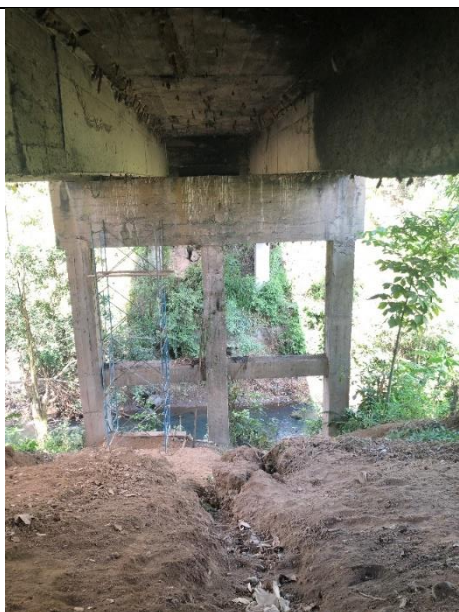
Ilustración A3. Pilas y viga cabezal C1.
