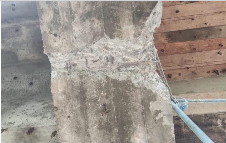
Ilustración C3. Acero de refuerzo longitudinal inferior existente en viga cabezal.
