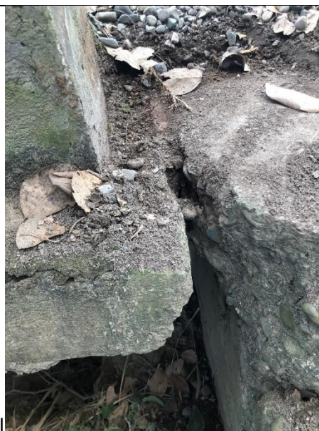
Ilustración A5. Junta entre puente y calzada de acceso.
