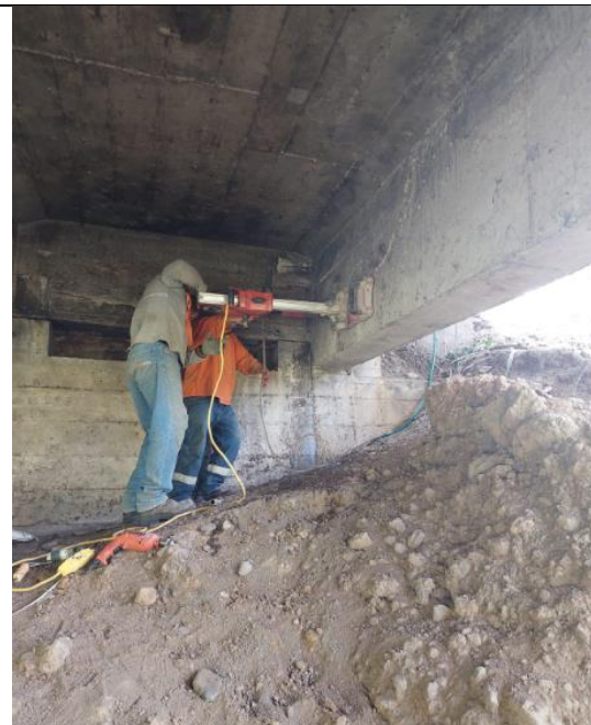
Ilustración B4. Toma de núcleo de Ho. En viga del puente
