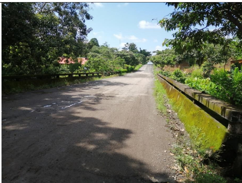
Ilustración A1. Tablero del puente río Jermud.
