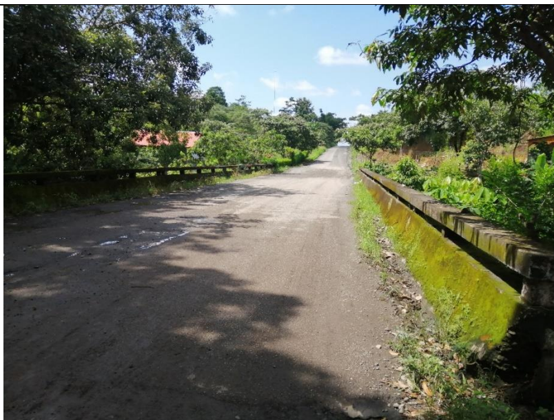
Ilustración A1. Tablero del puente río Jermud.
