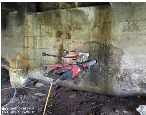
Ilustración B3. Toma de núcleo de Ho. en estribo derecho
