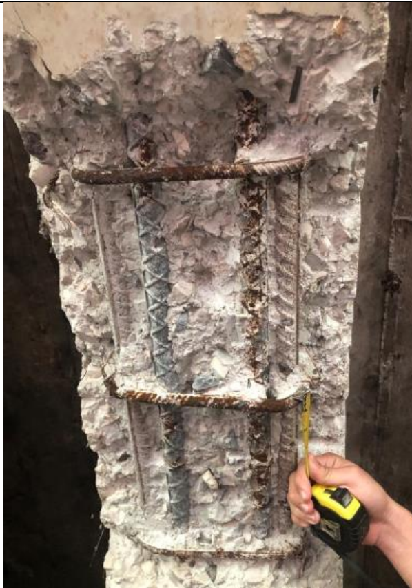
Ilustración C1. Acero de refuerzo longitudinal existente en viga del puente
