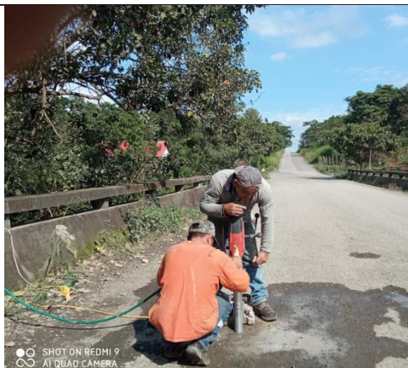
Ilustración B2. Toma de núcleo de Ho. en losa del tablero del puente
