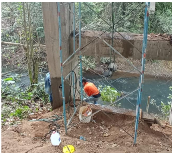
Ilustración B5. Toma de núcleo de Ho. en columna pila.
