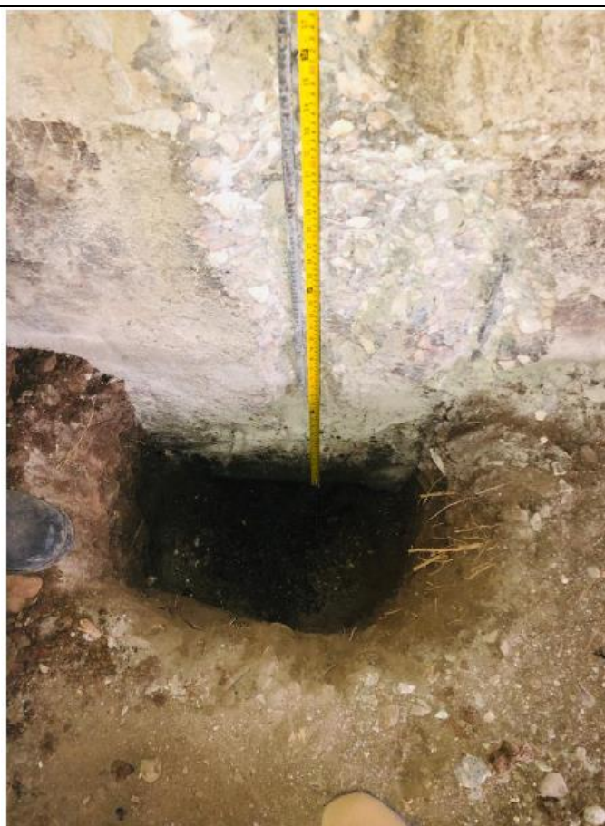
Ilustración C5. Acero de refuerzo en el estribo.
