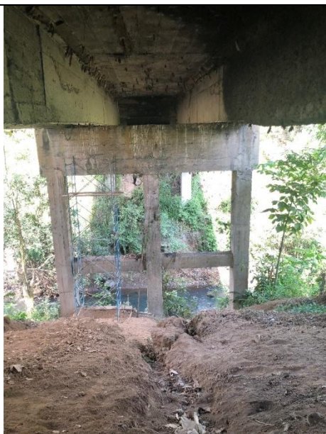
Ilustración A3. Pilas y viga cabezal C1.
