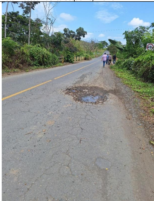
Foto: Acceso Puente Sequel El Limón, Dic 2024.
