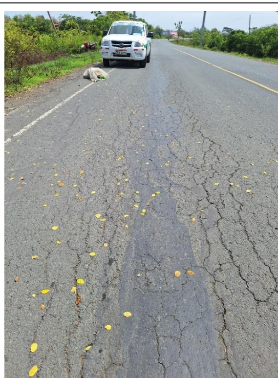
Foto: Acceso Puente Sequelillo, Dic 2024.
