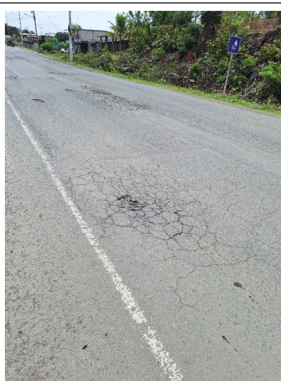
Foto: Acceso Puente Colimes, Dic 2024.
