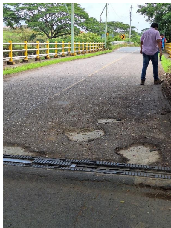
Foto: Acceso Puente Sequel, Dic 2024.
