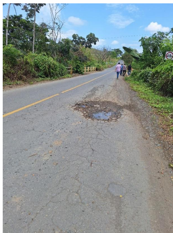
Foto: Acceso Puente Sequel El Limón, Dic 2024.
