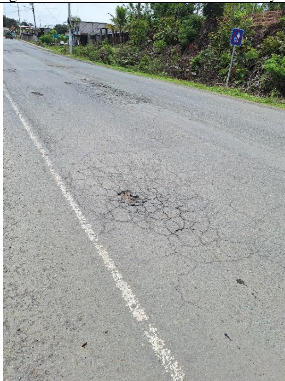
Foto: Acceso Puente Colimes, Dic 2024.
