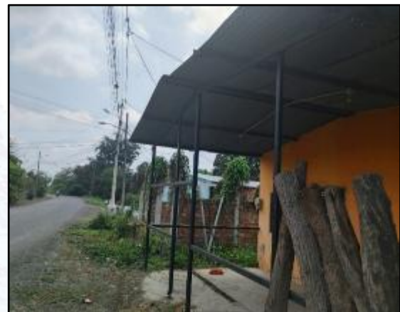
Afectación de cerramiento y galpón ubicado en el trazado vial, sector La Inmaculada.
