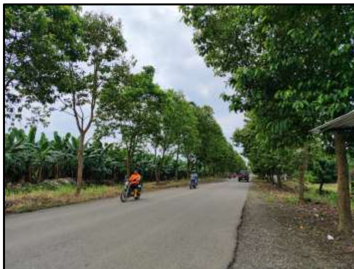
Figura 2. Registro fotográfico Tramo 1
