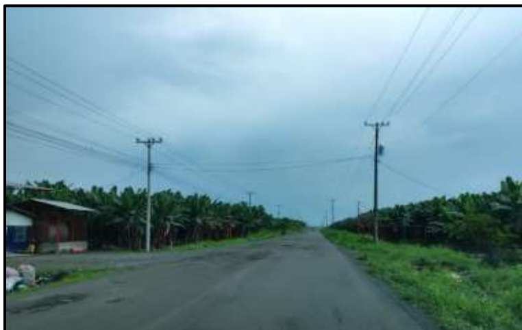
Figura 3. Registro fotográfico Tramo 2
