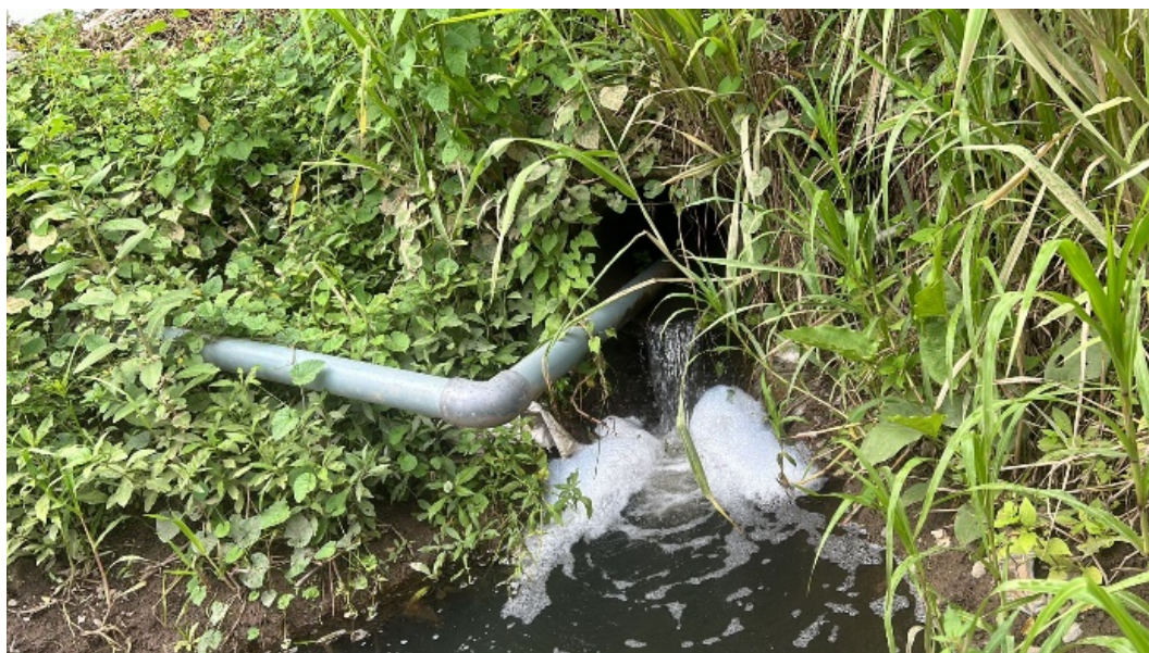
Figura 8. Tubería de 500 mm
