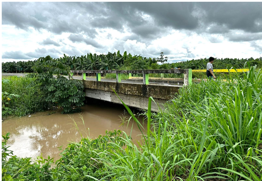
Figura 5. Presencia de vegetación en los márgenes del puente
