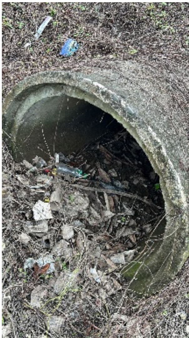
Figura 7. Tubería de 1200 mm
