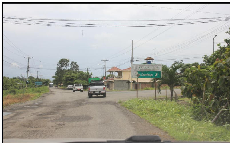
Figura 14 Vía a la comunidad Santo Domingo
