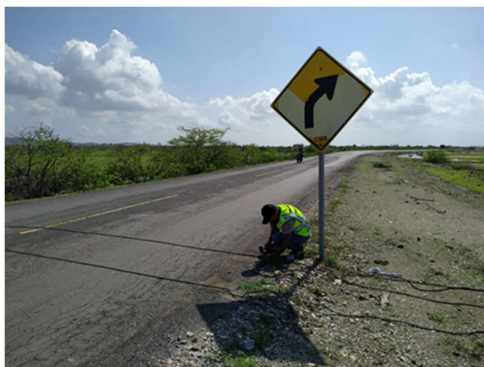
Figura 2.- Estado actual de la vía
