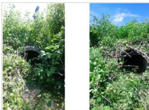
Ilustración 1 Estructuras de drenaje menor
