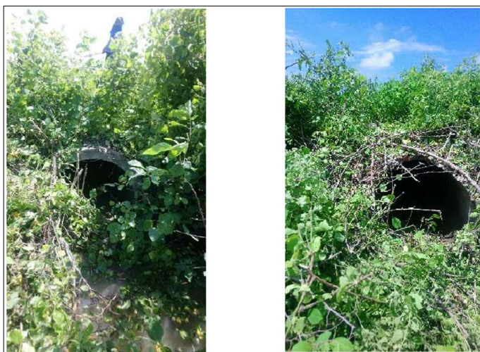
Ilustración 1 Estructuras de drenaje menor
