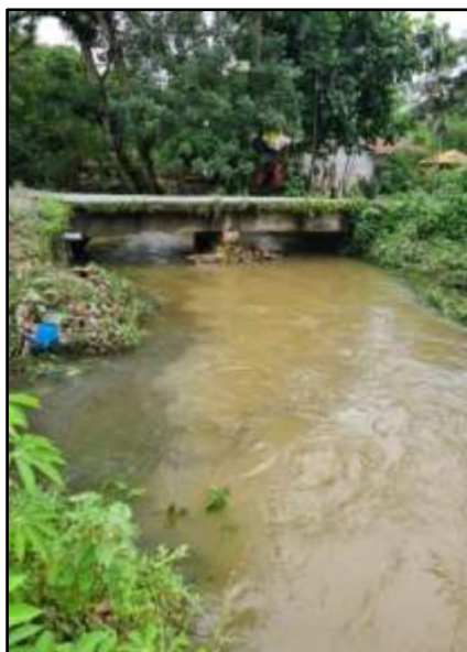
Figura 3. Puente Estero Milagro.
