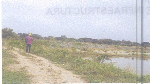
ESTADO ACTUAL DEL ENROCADO
