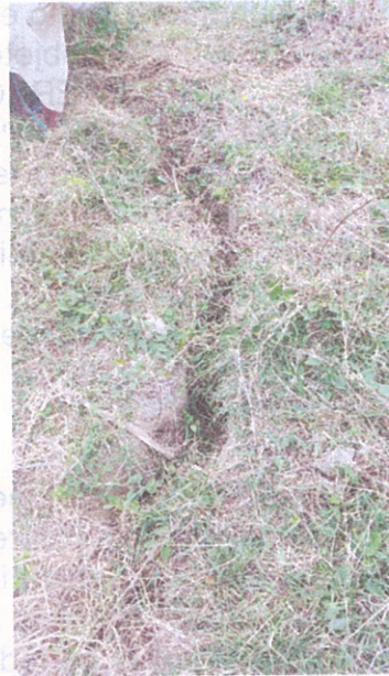
FISURA LONGITUDINAL POR EFECTO DEL ASENTAMIENTO PUNTUAL EN LA CORONA DEL MURO.
