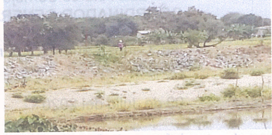
ESTADO ACTUAL DEL ENROCADO
