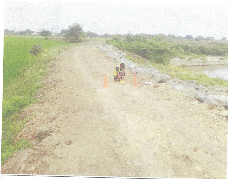
Reconformación de muro y toma de densidades de campo
