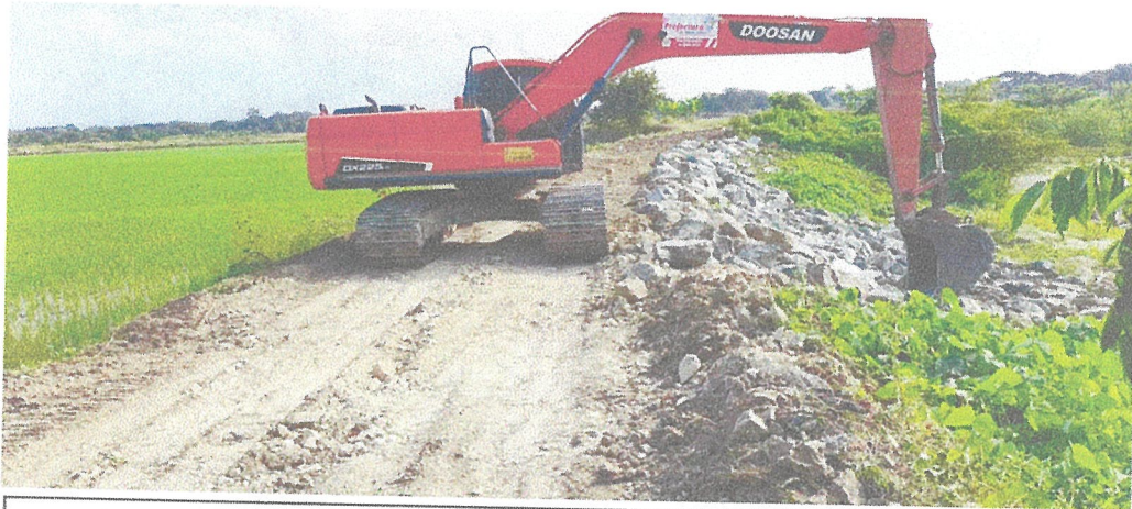
Colocación de rocas
