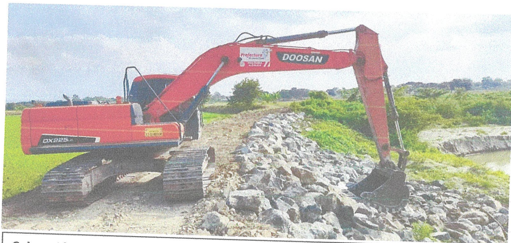
Colocación de rocas
