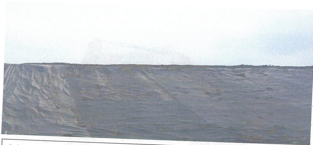
Colocación de geotextil
