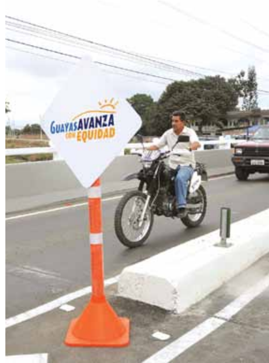
Tres tramos de rebasamiento en la vía Km. 26 - Puerto Inca - Naranjal
