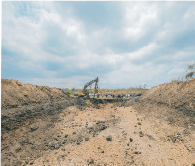
A las obras de vialidad se suman también las obras de riego. In addition to the road works, irrigation works have also been carried out.
