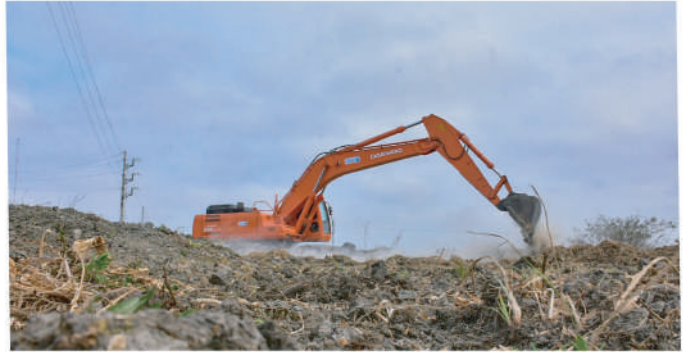
Se coloca nuevo material pétreo, para asegurar que la nueva vía sea más resistente. New stone material is placed to ensure that the new road is more resistant.
