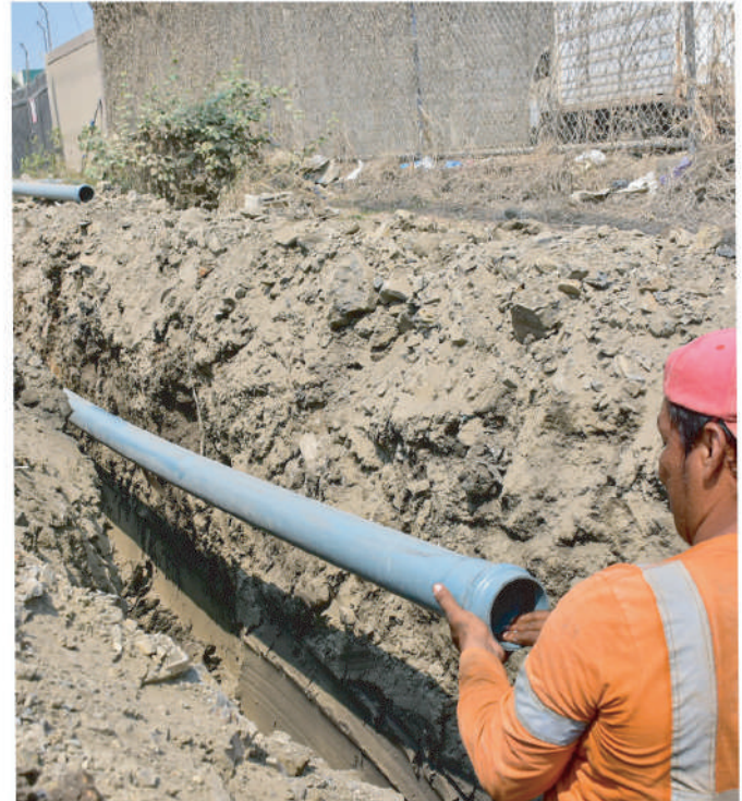
Como parte de la transformación de av. Tanasa, también se mejora el sistema de drenaje. As part of the transformation of Tanasa Avenue, the drainage system is also being improved.
