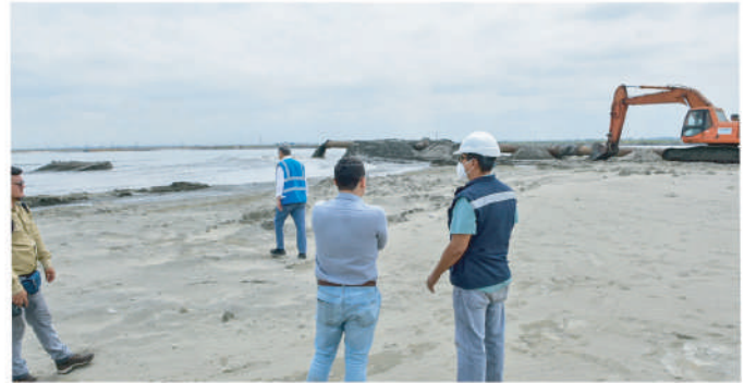
El sedimento es depositado en El Tejar y Terrenos Particulares I, en Durán. Sediment is deposited in El Tejar and Terrenos Particulares I, in Durán.
