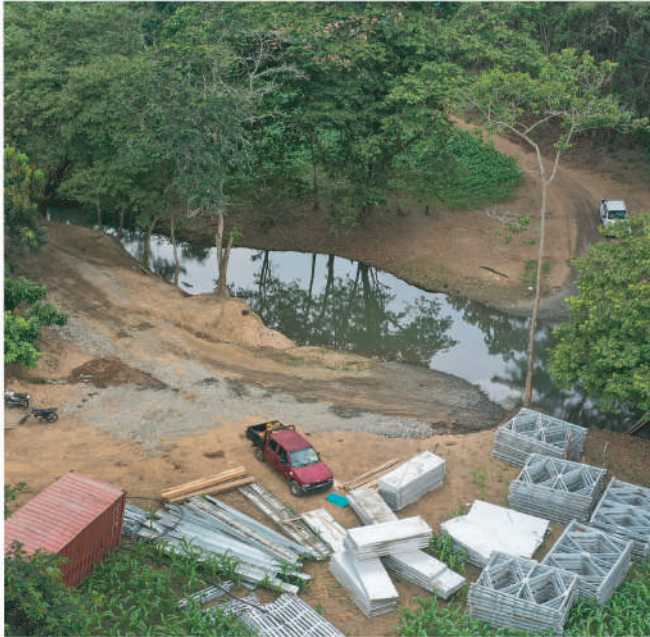
En El Empalme, el puente Bailey benefició a cientos de pobladores del recinto 2 de Mayo. In El Empalme, the Bailey bridge benefited hundreds of residents of the 2 de Mayo precinct.
