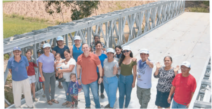
El vicepresidente Carlos Serrano inspeccionó la colocación del puente Bailey sobre el estero La Matilde, en Salitre. Vice-prefect Carlos Serrano inspected the placement of the Bailey bridge over the La Matilde estuary in
