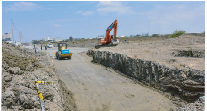
La creación de un nuevo anillo vial también permitirá descongestionar la vía Durán-Tambo. The creation of a new ring road will also decongest the Durán-Tambo road.
