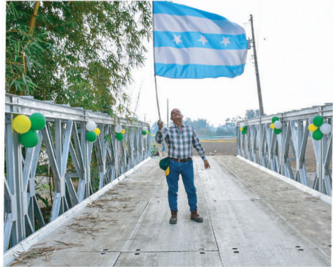
La bandera del Guayas ondea sobre uno de los puentes Bailey instalados en Marcelino Maridueña. The flag of Guayas flies over one of the Bailey bridges installed in Marcelino Maridueña.
