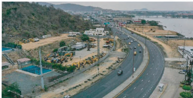
La prefecta Marcela Aguiñaga entregó una vía en perfectas condiciones y en un tiempo récord de 6 meses. Prefect Marcela Aguiñaga delivered a road in perfect conditions and in a record time of 6 months.
