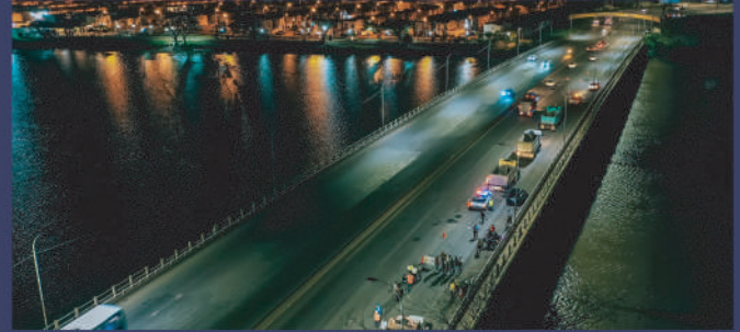
La calzada del puente Vicente Rocafuerte fue rehabilitada como parte de la intervención de la avenida León Febres Cordero. The roadway of the Vicente Rocafuerte bridge was rehabilitated as part of the intervention of León Febres Cordero Avenue.
