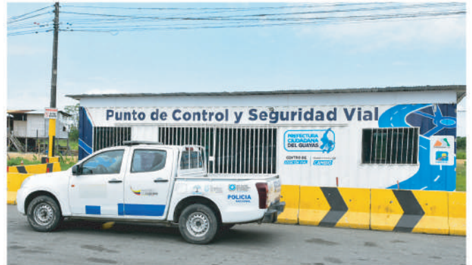
Cada Punto de Control y Seguridad Vial consiste en contenedores climatizados que funcionan como centro de monitoreo. Each Road Safety and Control Point consists of climate-controlled containers that function as a monitoring center.
