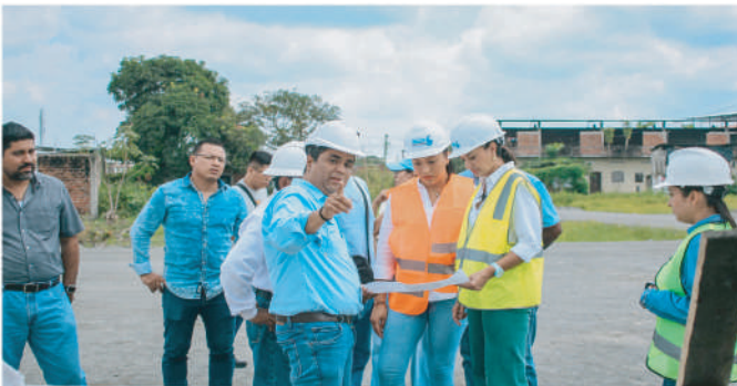
La prefecta Aguiñaga inspeccionó los avances de Construyendo Vidas. Prefect Aguiñaga inspected the progress of Construyendo Vidas.
