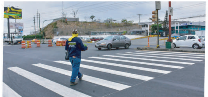
La rehabilitación de la vía presenta un beneficio directo para miles de personas que viven en sus alrededores. The rehabilitation of the road is of direct benefit to thousands of people living in the surrounding area.
