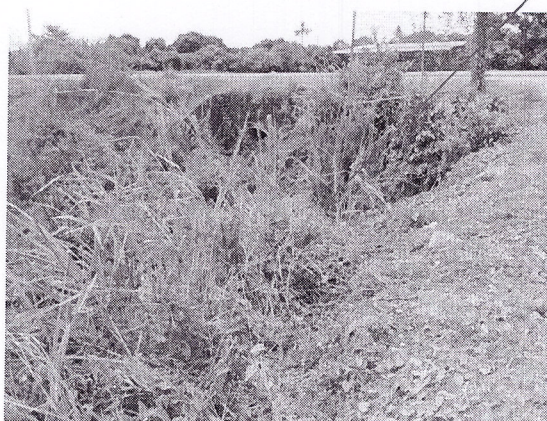
Abscisa 6+955 Alcantarilla H.A. Doble \varnothing 1.50 m, en buen estado, con malezas
