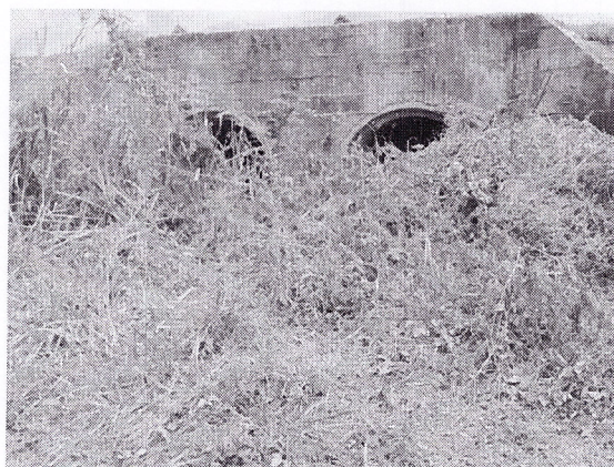
Abscisa 6+955 Alcantarilla H.A. Doble \varnothing 1.50 m, en buen estado, con malezas
