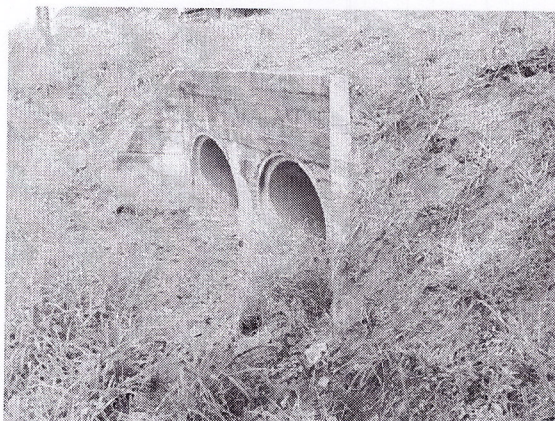
Abscisa 6+727 Alcantarilla H.A. \varnothing 0.90 m, con malezas
