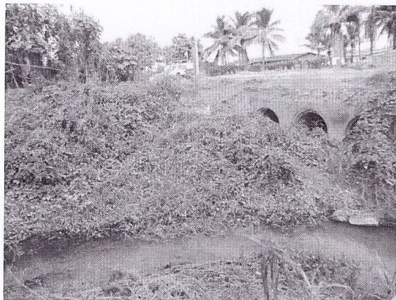
Abscisa 3+127 Alcantarilla H.A. Ducto Cajón 0.90 x0.90m, con maleza
