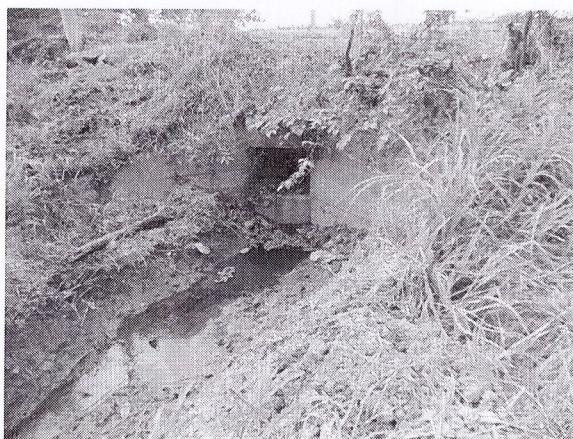
Abscisa 3+430 Alcantarilla H.A. Doble \varnothing 1.50m, en buen estado
