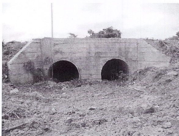
Abscisa 3+430 Alcantarilla H.A. Doble \varnothing 1.50m, en buen estado
