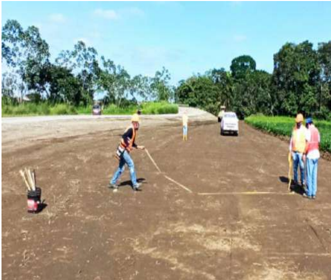
Foto #7. Equipo de topografía replanteando terreno
