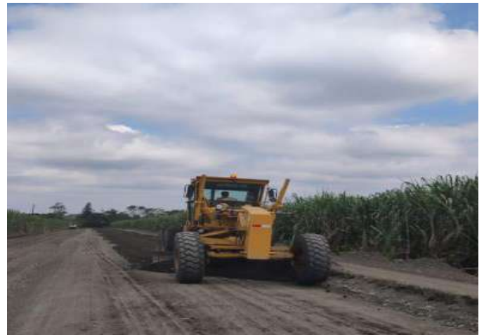
Foto #4. Reconformación de terreno
