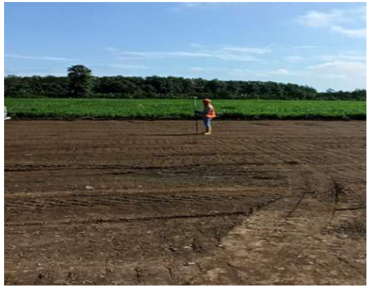
Foto #8. Equipo de topografía replanteando terreno
