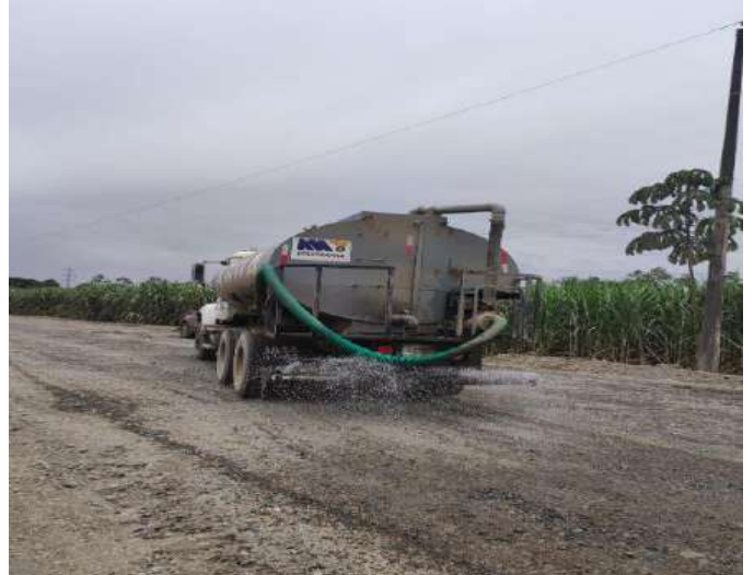
Foto #6. Riego de agua para control de polvo
