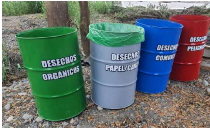
Se puede apreciar en la foto la disposición de los tanques de 55 Galones para los desechos (basura) en la obra.
