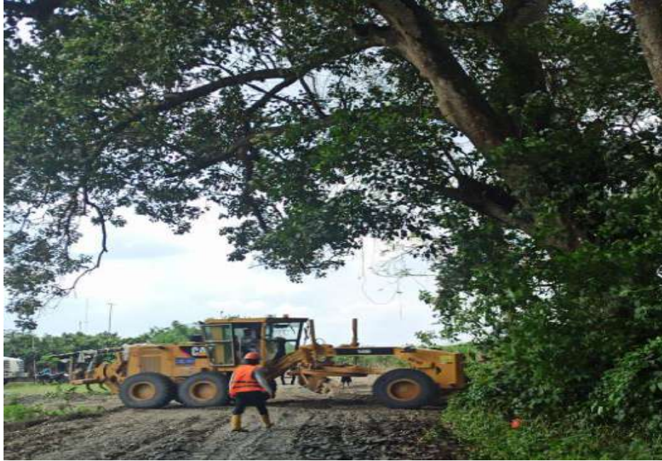
303-2(1) EXCAVACION SIN CLASIFICAR (c/tractor, empuje 60 m)
