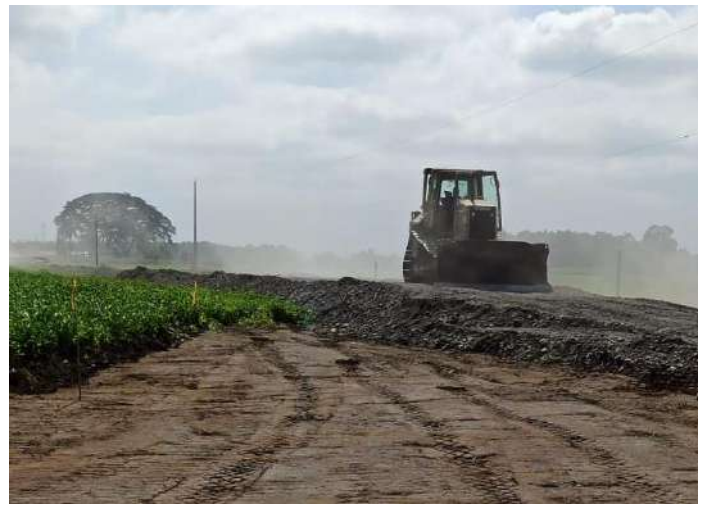
Foto #2. Relleno con material de préstamo importado
