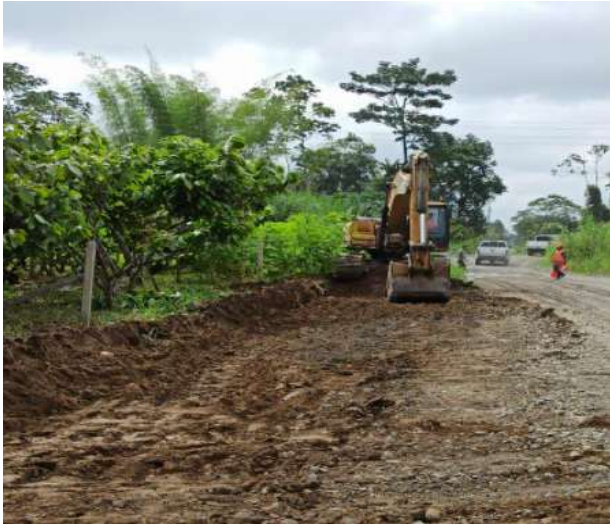
Foto #5. Excavación sin clasificar.
