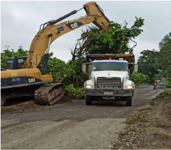
Foto #1. Desbroce y limpieza
