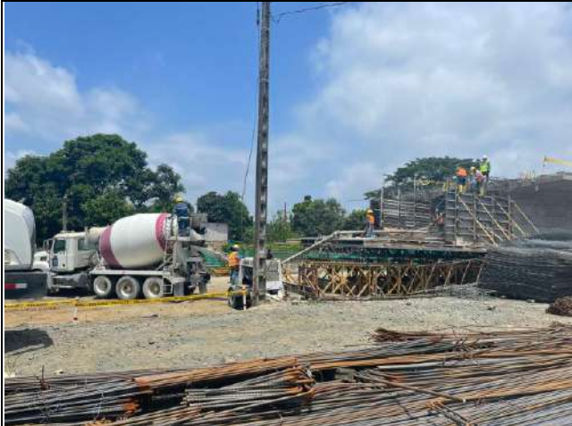
HORMIGÓN ESTRUCTURAL DE CEMENTO PORTLAND, CLASE A(*) F'C=450 KG/CM 2 (DOVELAS, BLOQUES DE ANCLAJE, DESVIADORES Y DIAFRAGMAS), EN FUNDICIÓN DE DOVELA 8 TRAMO TIERRA, MARGEN IZQUIERDA
