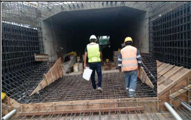
HORMIGÓN ESTRUCTURAL DE CEMENTO PORTLAND, CLASE A(*) F'C=450 KG/CM 2 (DOVELAS, BLOQUES DE ANCLAJE, DESVIADORES Y DIAFRAGMAS), EN FUNDICIÓN DE DOVELA 8 TRAMO TIERRA, MARGEN IZQUIERDA
