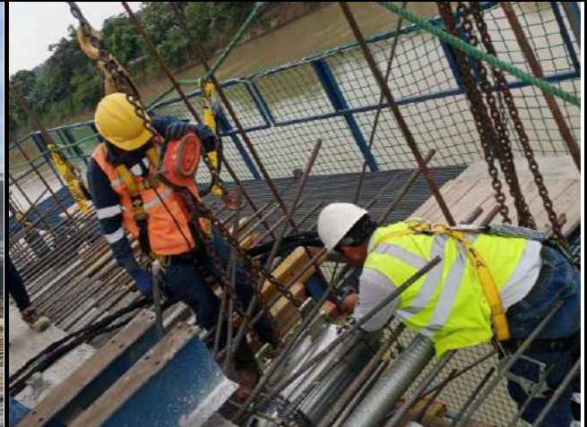
ACERO PARA PRECOMPRESIÓN EN TORONES DE BAJA RELAJACIÓN FRG=19000 KG/CM 2 (PREESFUERZO LONGITUDINAL DE CONSTRUCCIÓN, DE CIERRE Y DE CONTINUIDAD)
