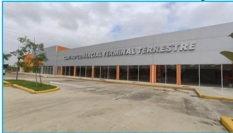
Ilustración 33: Terminal Terrestre de Milagro
