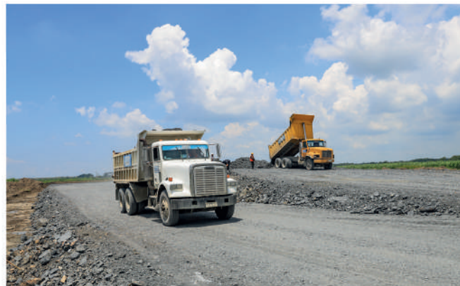
En convenio con el MTOP, la Prefectura Ciudadana del Guayas construye las vías de acceso al Quinto Puente. In agreement with the MTOP, the Guayas Prefecture is building the access roads to the Fifth Bridge.
