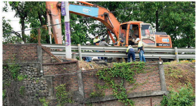
Los puentes de la provincia también reciben obras de mantenimiento y mejoramiento. The bridges of the province also receive maintenance and improvement works.
