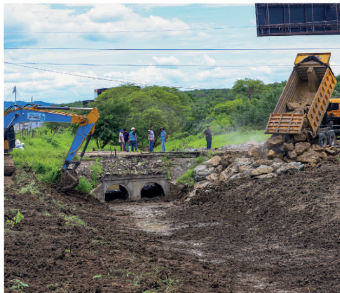
Obras en muros, ríos y esteros, fueron ejecutadas por la Prefectura Ciudadana del Guayas para proteger a la población en zonas rurales. Works on walls, rivers and estuaries were carried out by the Guayas Prefecture to protect the population in rural areas.
