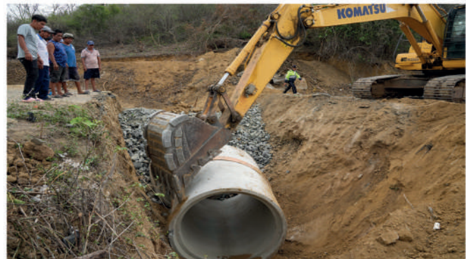
Con las obras de drenaje, se trabaja en obras de prevención en las zonas rurales. With drainage works, we work on prevention works in rural areas.
