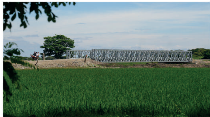
Con la instalación de puentes Bailey, se une a comunidades que permanecieron aisladas por muchos años. With the installation of Bailey bridges, communities that have been isolated for many years are connected.
