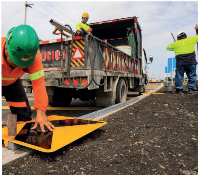
Las nuevas vías del Guayas son más resistentes. Los trabajos se realizan donde realmente se necesitan. The new roads of Guayas are more resistant. The works are carried out where they are really needed.
