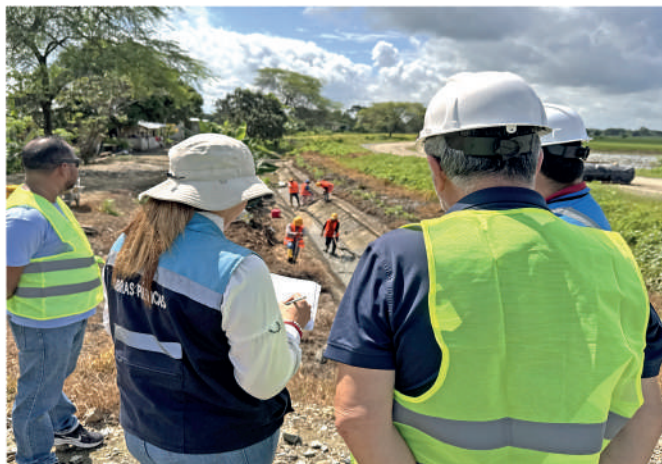
En el sector rural también se trabaja en los canales para garantizar las obras de riego y proteger a las poblaciones. In the rural sector, work is also being carried out in the canals to guarantee irrigation works and protect the populations.
