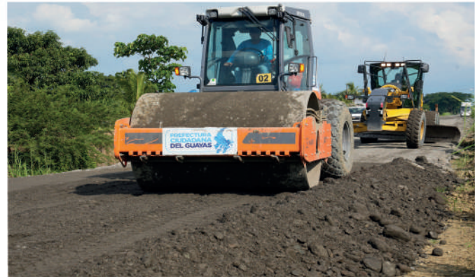
A nivel de caminos vecinales y obras secundarias, se trabaja en vías resistentes y que duren por muchos años. At the level of local roads and secondary works, work is being done on roads that are resistant and will last for many years.
