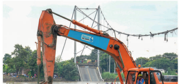
Una vez concluyan las labores de extracción de la estructura colapsada, se construirá un nuevo puente. Once the extraction of the collapsed structure is completed, a new bridge will be built.
