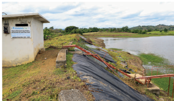
El uso de geomembranas también permite la protección de las riveras de los cuerpos hídricos y nuevas obras de infraestructura. The use of geomembranes also makes it possible to protect the banks of water bodies and new infrastructure works.
