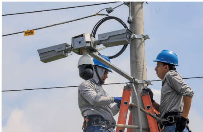
Con cámaras y obras de infraestructura se protege los planteles educativos en las zonas más vulnerables. Cameras and infrastructure works are used to protect schools in the most vulnerable areas.
