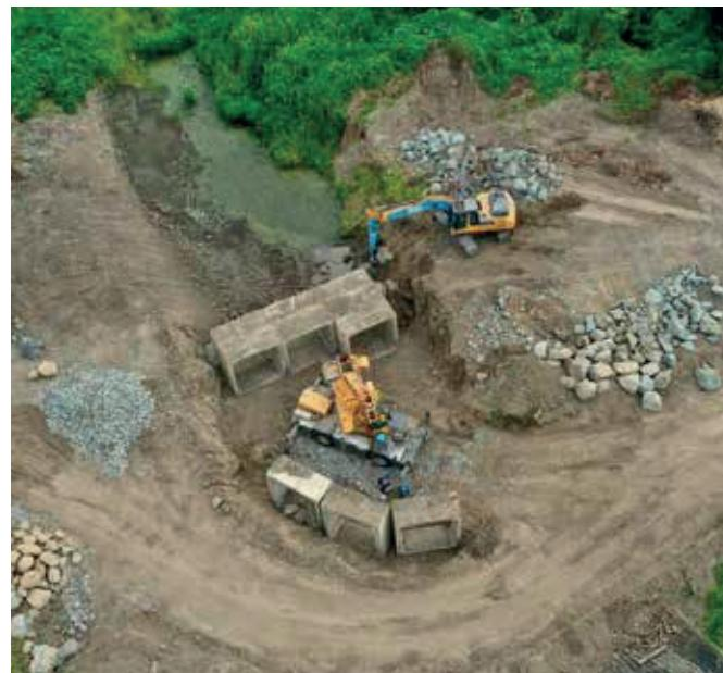
La colocación de tuberías y ductos cajones es parte de las obras de prevención.
